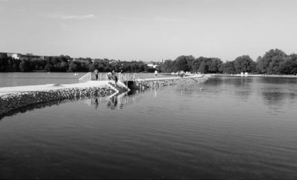
Wasser kann dennoch in die Bucht einströmen, durchfließt aber eine Regenerationszone (Pflanzenfilter), wodurch die Wasserqualität in diesem Bereich verbessert wird.
