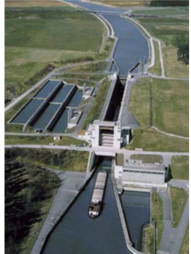
(Bild 1: Schachtschleuse mit Sparbeckenreihen, Foto WSA Nürnberg)
